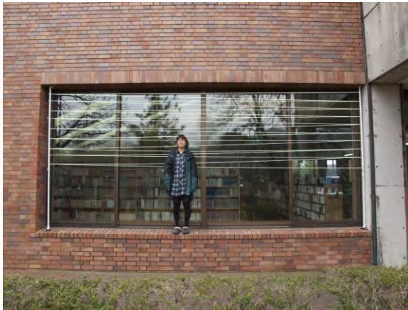
図 8 釣り糸による衝突防止策
